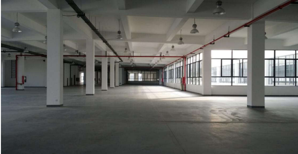
图 2-3 结构试验大厅副厅部分
